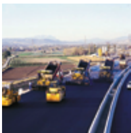
Imagen de los equipos de extendido de mezclas asfálticas en caliente, de la empresa, en plena actividad. Al fondo, la planta móvil de fabricación de mezclas asfálticas en caliente.
